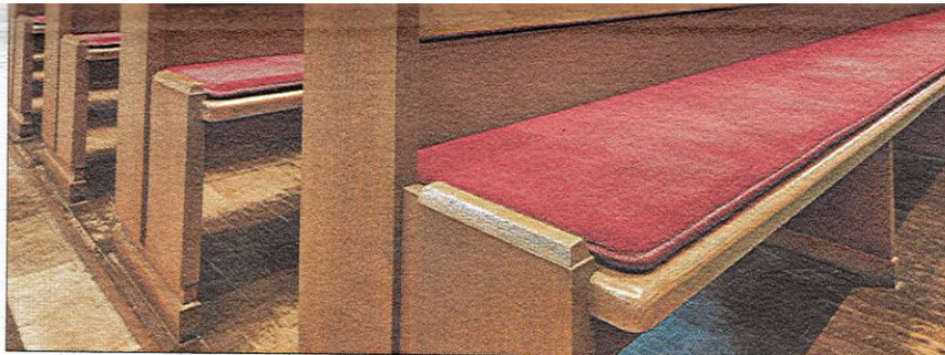
▲ In der Andreaskirche in Hildesheim sorgen rote Sitzpolster mit integrierter Heizung für angenehme Wärme. Foto: P. R. Havener GmbH
